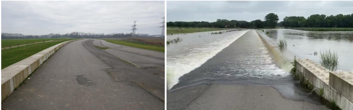
Figuur: Inlaatdempel bij retentiegebied LKW. Links een archieffoto vanuit het zuiden, rechts een foto tijdens het hoogwater vanuit het noorden.
