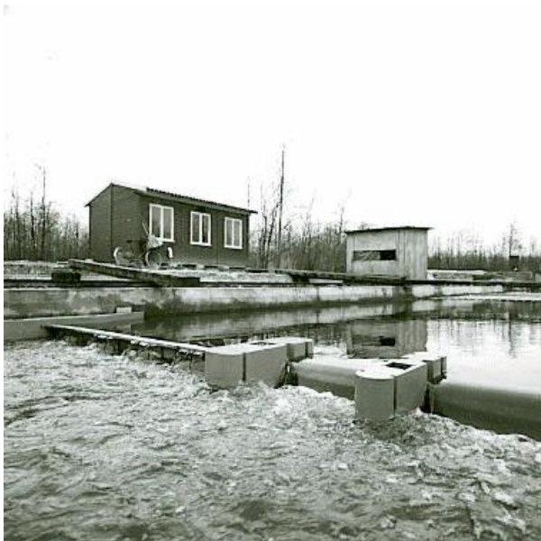
Schaalmodel van de stuw bij Sambeek; Waterloopkundig Laboratorium, 1967. (bron: Deltares)
